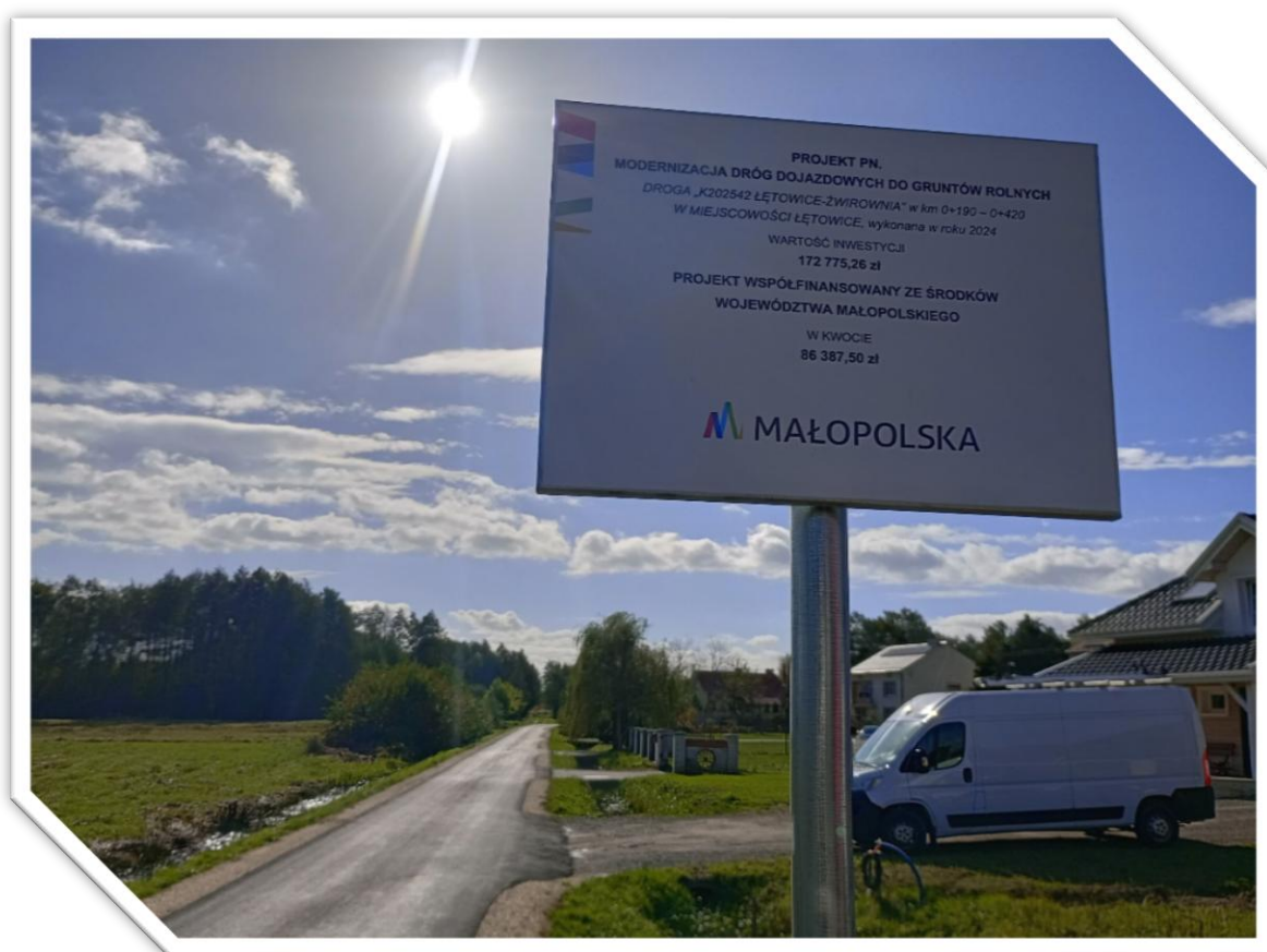
„Remont i modernizacja drogi gminnej K202542 Łętowice – Zwirownia dz. nr 1106/3 w km 0+190 – 0+420”.
