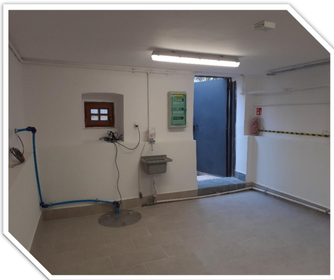
„Remont zabytkowego budynku Domu Ludowego im. Wincentego Witosa w Wierzchosławicach z 1924 r.”
