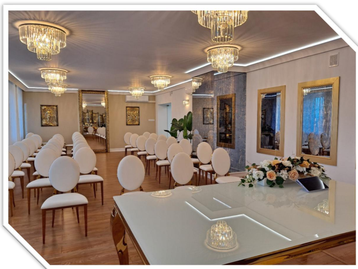
„Modernizacja i remont Sali Ślubów w budynku Urzędu Gminy Wierchosławice”.
