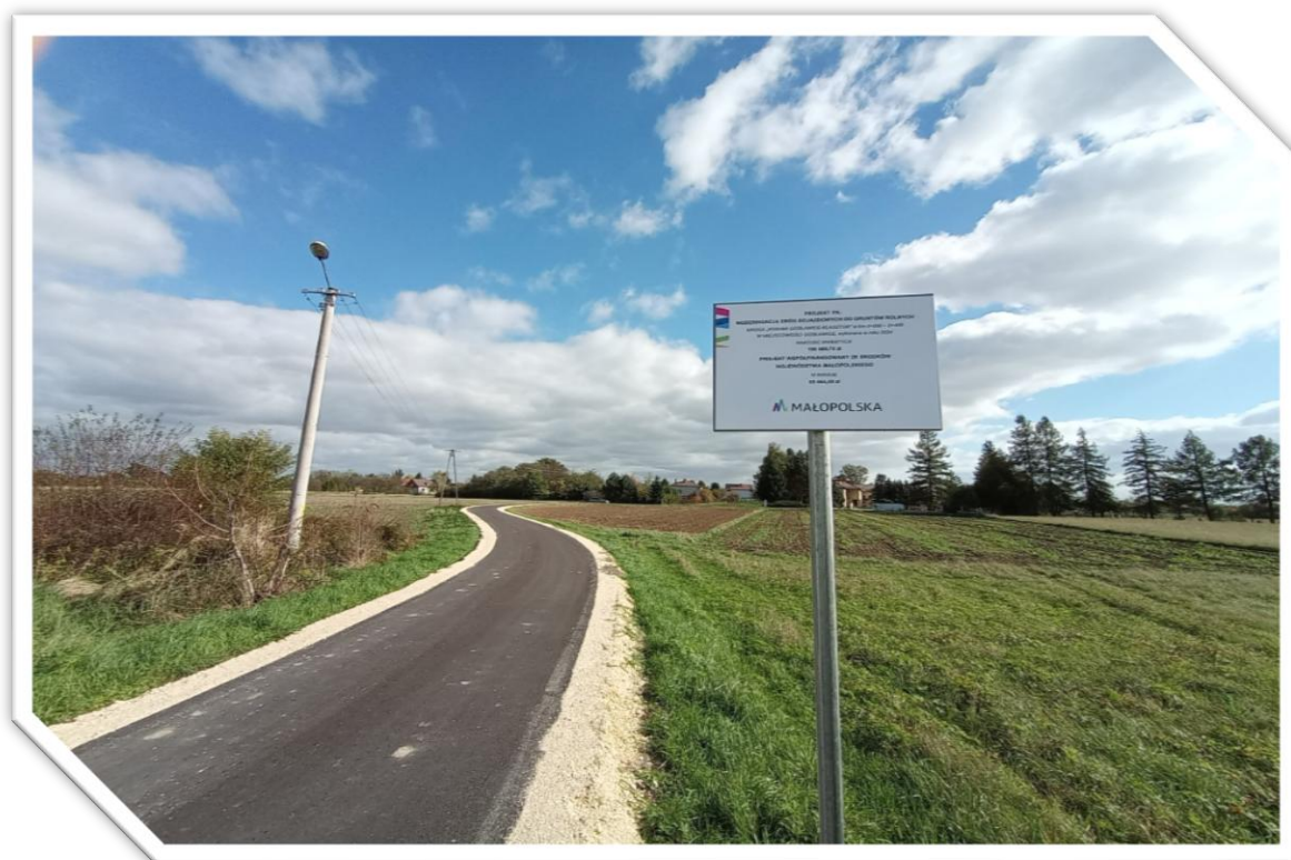
„Remont i modernizacja drogi gminnej K202498 Gostawice-Klasztor w km 0+000-0+400”.
