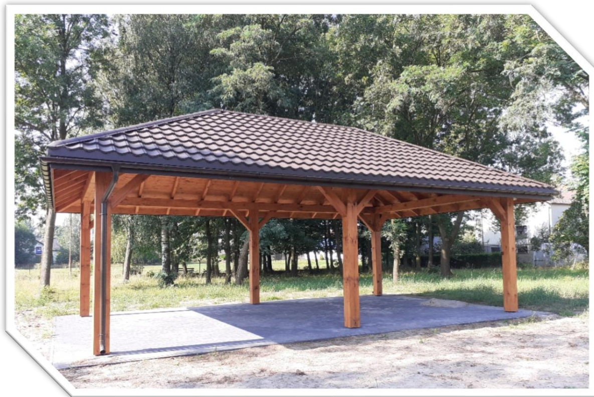
„Budowa wiaty grillowej przy Domu Ludowym w Łętowicach”.
