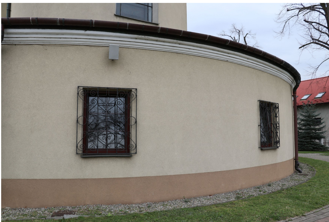
fot. 35: Elewacja tylna - okna z kratownicami elewacji zakrystii.
