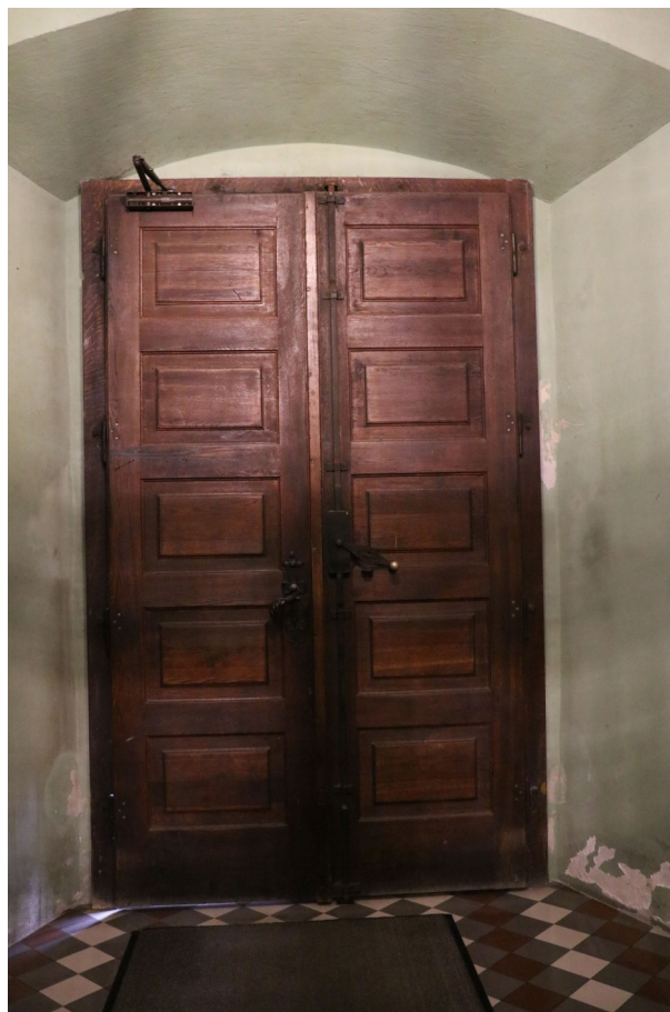
fot. 10: Drzwi wejściowe do kościoła widoczne od wewnątrz.
