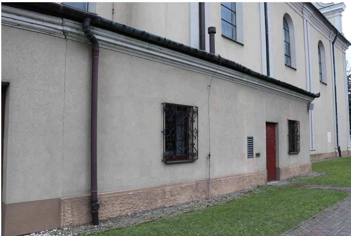
fot. 40: Elewacja południowa - widok elewacji zakrystii.
