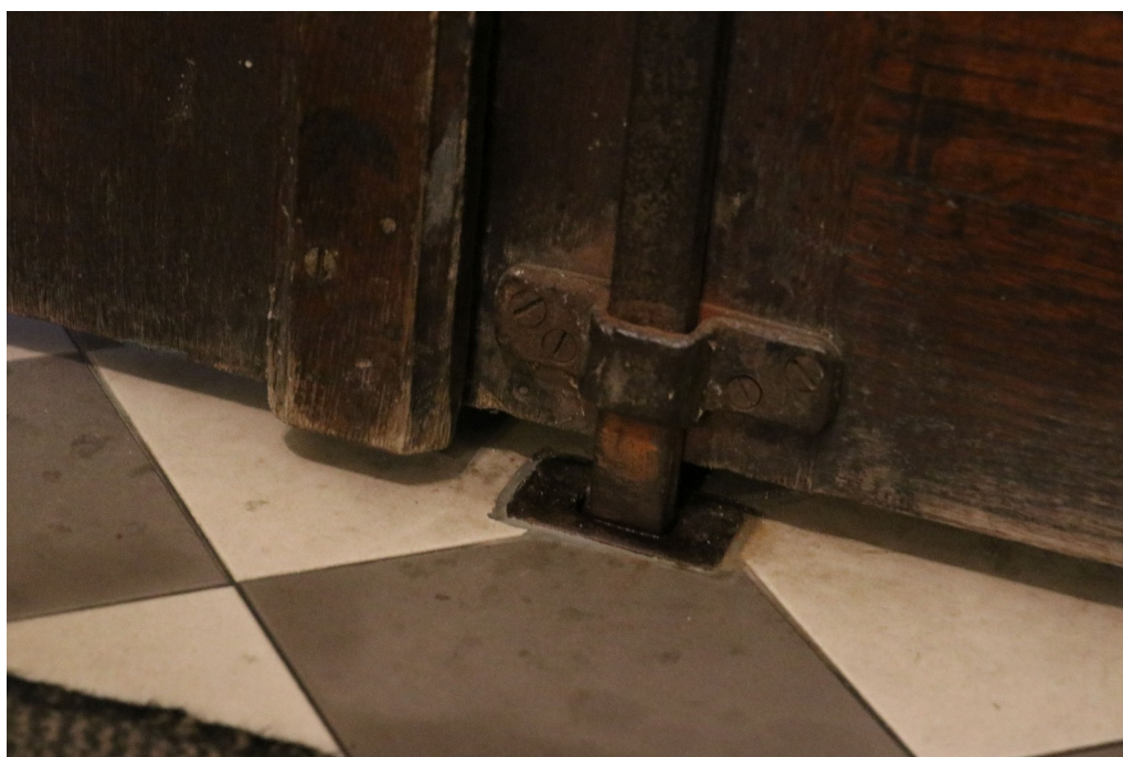
fot. 11: Mocowanie skobła dolnego drzwi wejściowych do kościoła.
