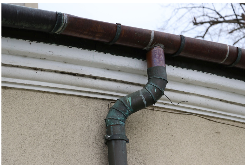
fol. 33: Elewacja południowa - nowa rynna i lej spustowy wymieniony z powodu uszkodzenia przez powalone drzewo.
