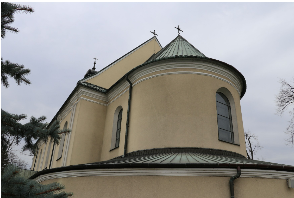
fot. 34: Elewacja tylna - widok ogólny.
