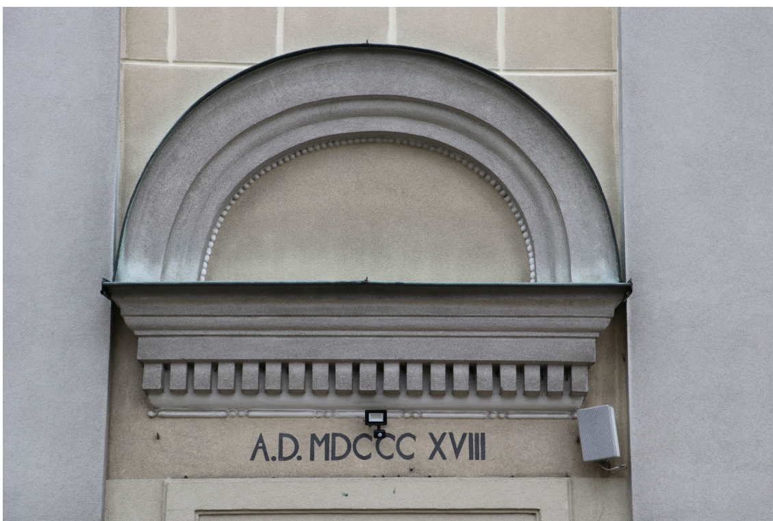
fot. 5: Elewacja frontowa - półkolisty przyczółek nad drzwiami wejściowymi.
