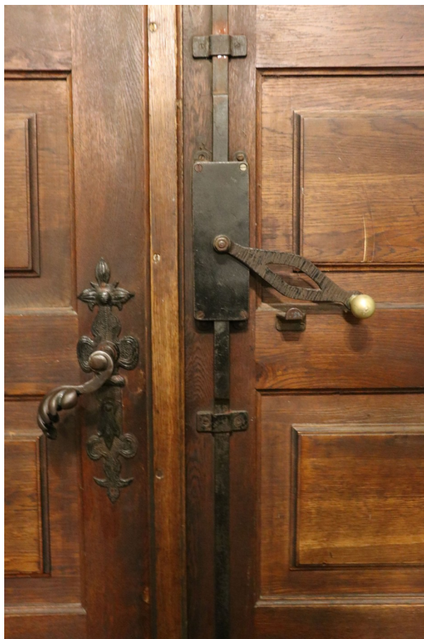
fot. 13: Okucia i klamka drzwi wejściowych do kościoła.
