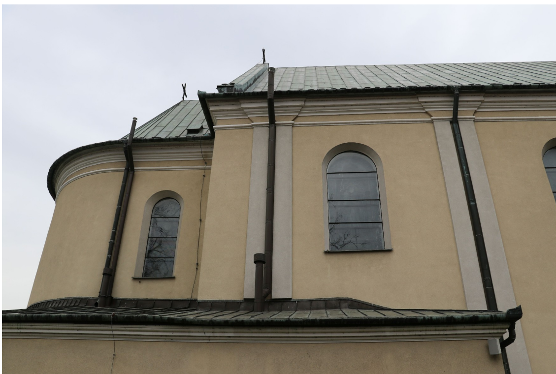
fot. 41: Elewacja południowa - widok ogólny.
