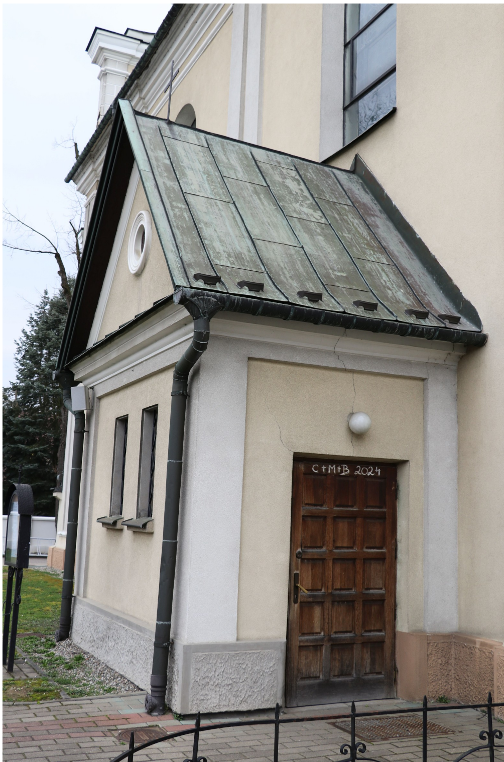
fot. 25: Elewacja południowa - kuchta z drzwiami wejściowymi.
