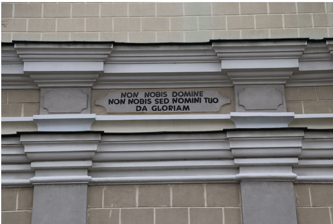
fot. 4: Elewacja frontowa - prawdopodobnie wtórny napis na płycinie osi środkowej elewacji.
