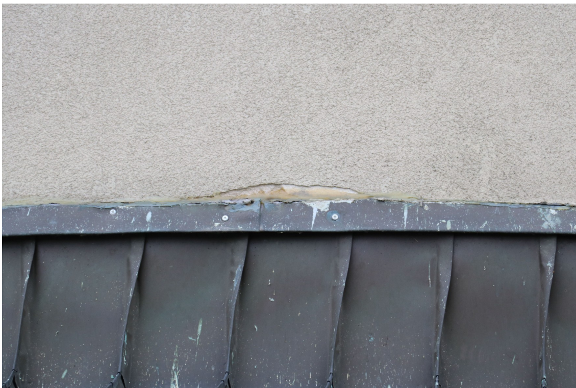
fot. 36: Elewacja tylna - odkrywka naturalna elewacji prezbiterium. Ujawnia kolor ugrowy tynku pierwotnego.
