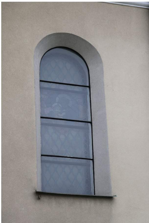
fot. 28: Elewacja południowa - otwór okienny z witrażem oraz szkleniem osłonowym.
