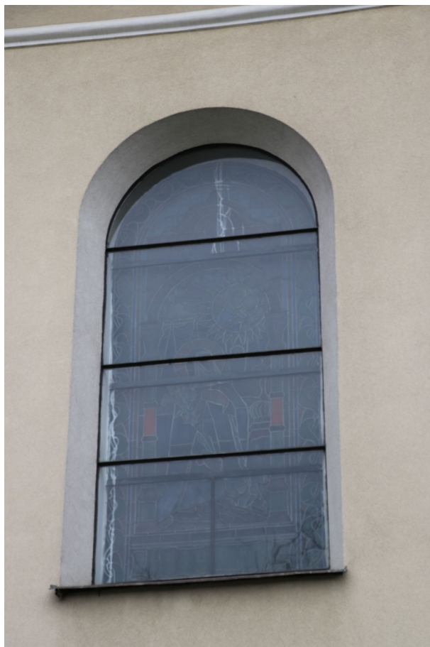
fot. 29: Elewacja południowa - otwór okienny z witrażem i szkleniem osłonowym.
