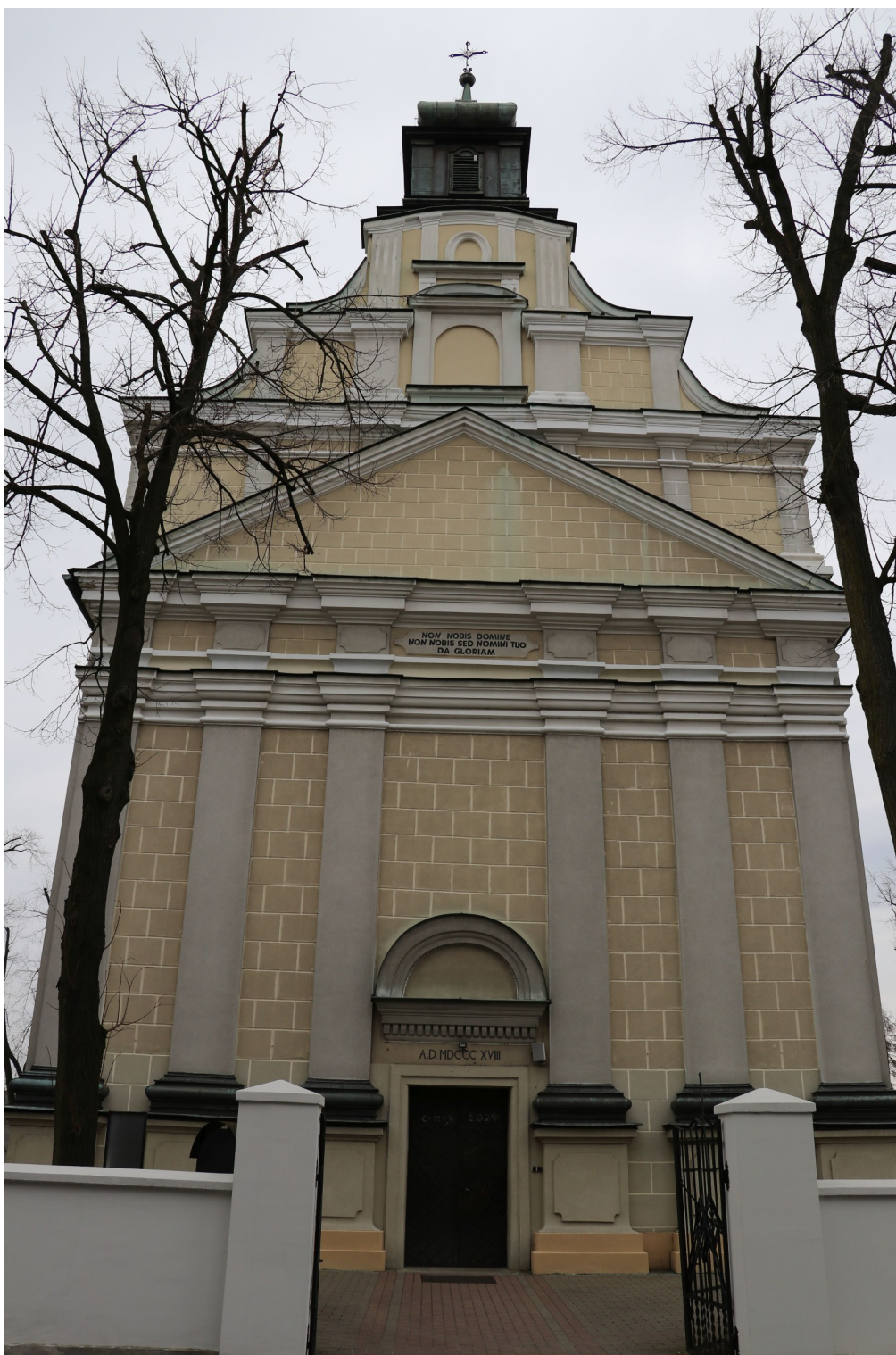
fot. 1: Elewacja frontowa - widok ogólny.
