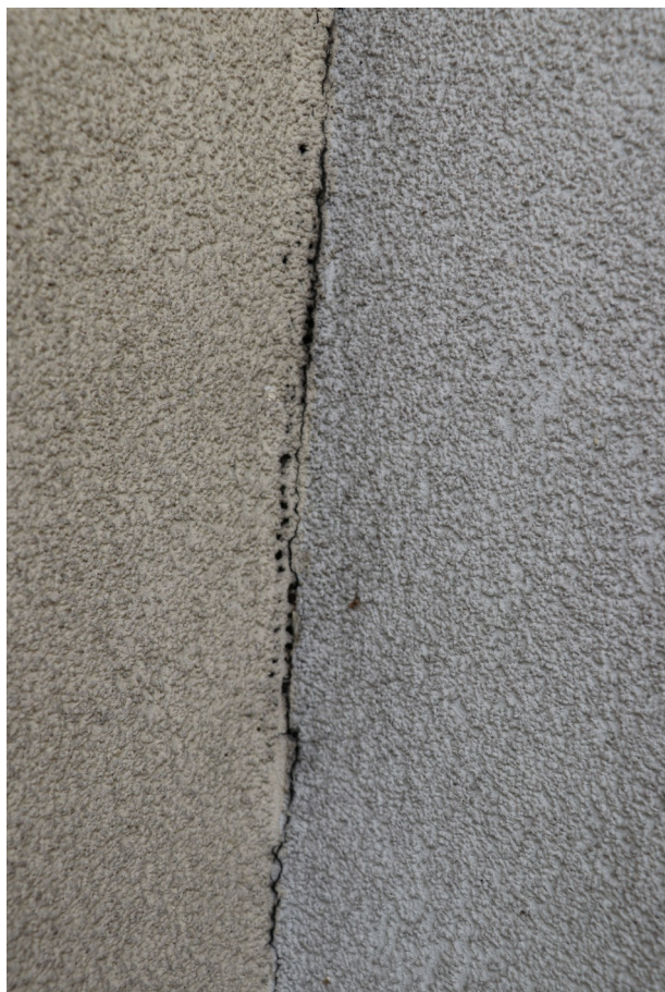
fot. 22: Elewacja południowa - siatka elewacyjna umieszczona w strukturze tynku wierzchniego elewacji.
