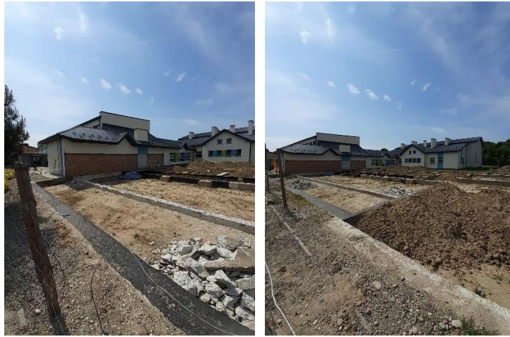
Przebudowa i rozbudowa budynku szkoły w Rudce
