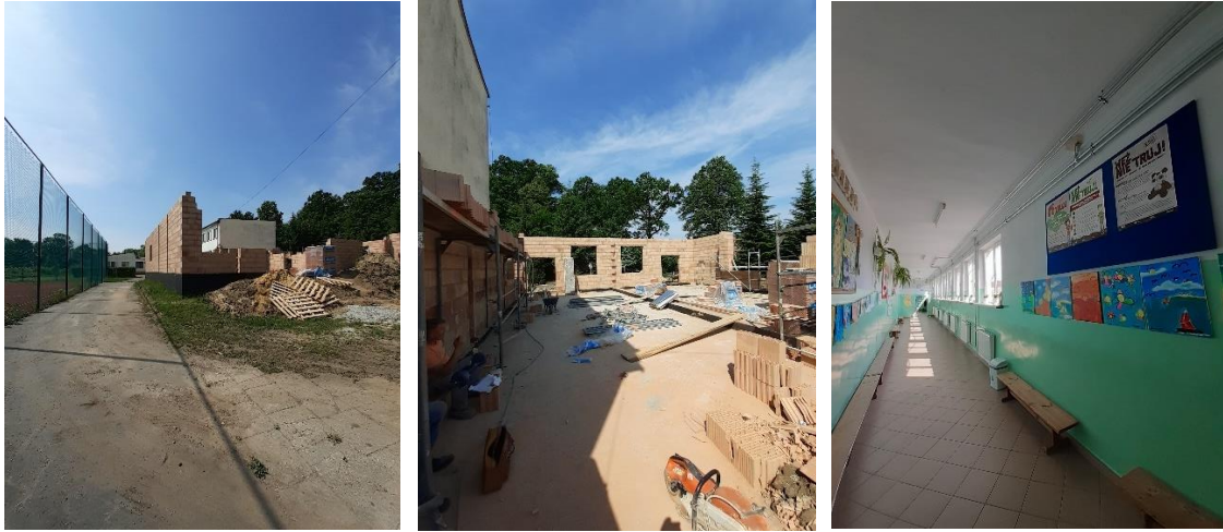
Przebudowa i rozbudowa budynku szkoły w Łętowicach
